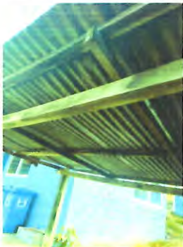
Foto1: Sustitución de cubierta de techo con lámina galvanizada, Tipo de lámina: troquelada Calibre: 26, incluye: fijaciones y sellado en traslapes.
